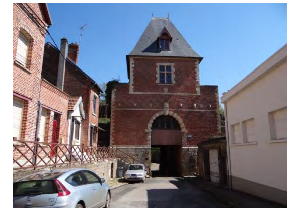
Photo 26 : Porte de Bretagne classée de Péronne (Source : BE JC)
