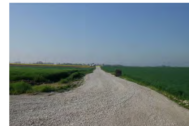
Photo 44 : Exemple de chemin d'accès après renforcement (Source : BE Jacquel et Chatillon)
