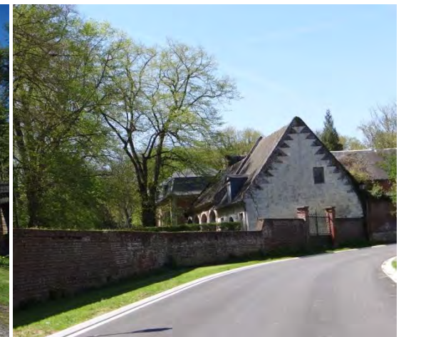
Photo 38 : Habitation à Suzanne (Source : BE JC)
