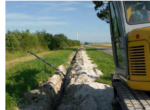
Photo 51 : Pose de câbles électriques et réalisation de tranchée à la pelle mécanique (Source : BE Jacquel et Chatillon)
