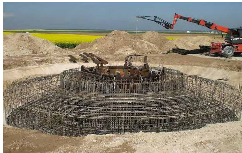
Photo 49 : Exemple de maillage d'acier d'armature pour fondation d'éoliennes de type massif poids (Source : BE Jacquiel et Chatillon)
