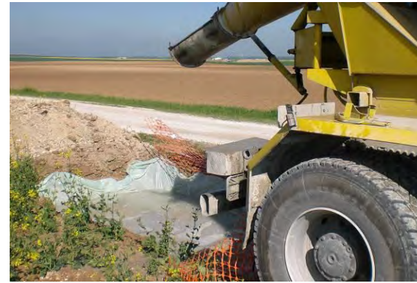
Photo 57 : Exemple de récupération des laitances de béton (Source : BE Jacquel et Chatillon)
