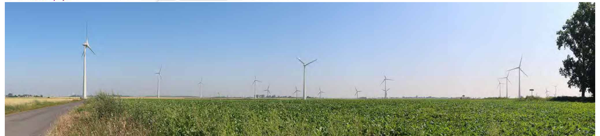
Figure 78 : Vue illustrative et photomontage 20 depuis la D930 entre Rethonvillers et Roye, à 3 608 m du projet, angle de 120° (Source : BE JC)
