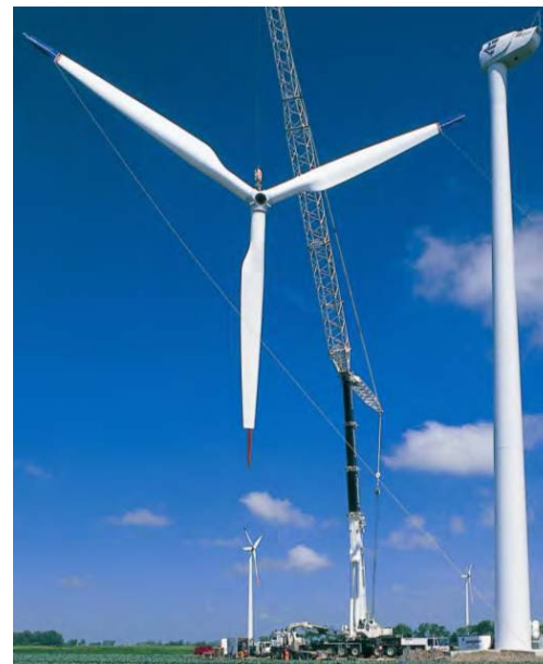
Photo 42 : Exemple de montage d'un rotor d'éolienne (Source : SENVION)
