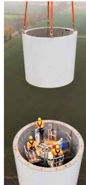
Photo 41 : Assemblage d'un mât d'éolienne (Source : SENVION)
