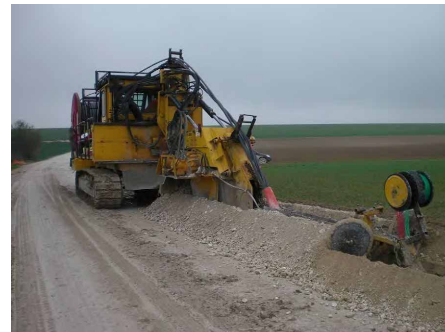
Photo 52 : Pose mécanisée de câbles électriques (Source : BE Jacquel et Chatillon)
